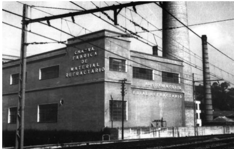
Imagen 1.1.1. Vista exterior de la antigua fábrica de Aristegui Material Refractorio S.A.
